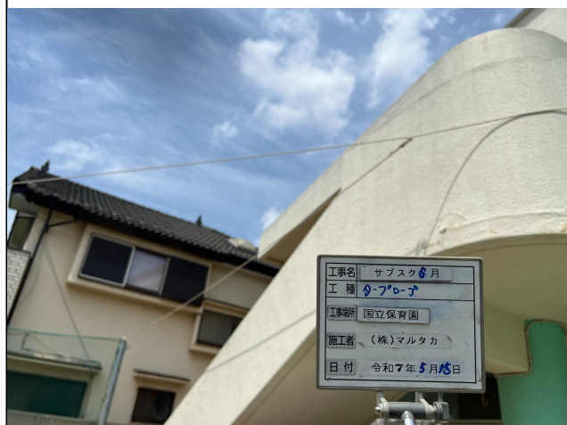
⑤その他 タープロープ張り
